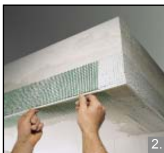
2. Plaatsing van een hoekprofiel met druipneus.
