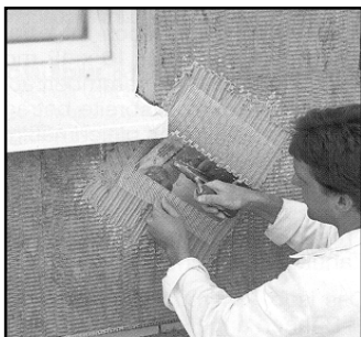
Plaatsen van de diagonaalstroken.
