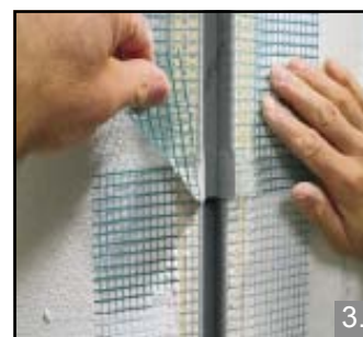
3. Plaatsing van een dilatatieprofiel.
