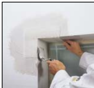
Aanbrengen van de weefselstroken in de binnenhoeken.
