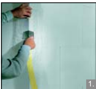
1. Plaatsing van een hoekprofiel (Sto Rolleckwinkel)
