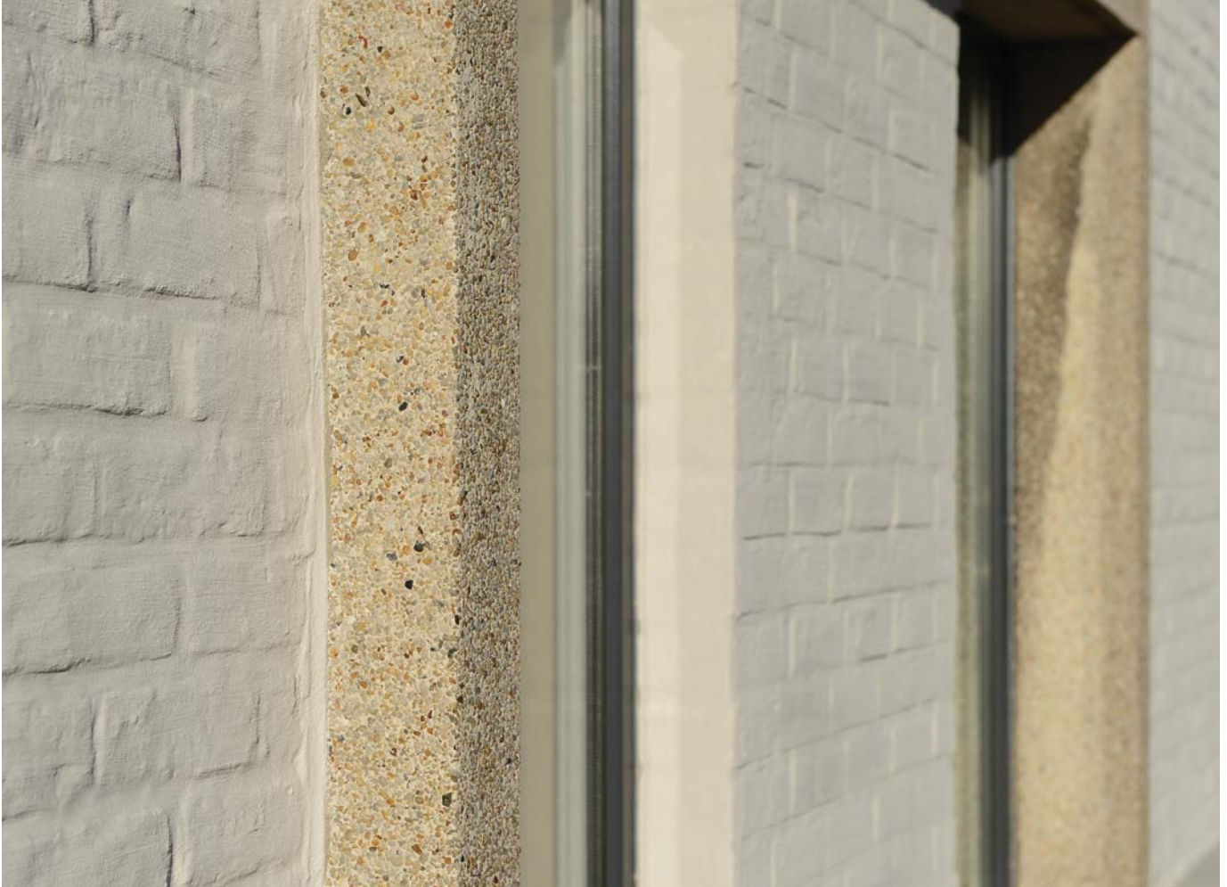
Foto's links en rechts: Renovatie woning te Brugge, BE
