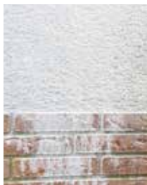
Afgeregende gevel zonder QS-Technologie of Additiv-WE
