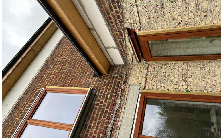
Photo après ajustements constructifs
