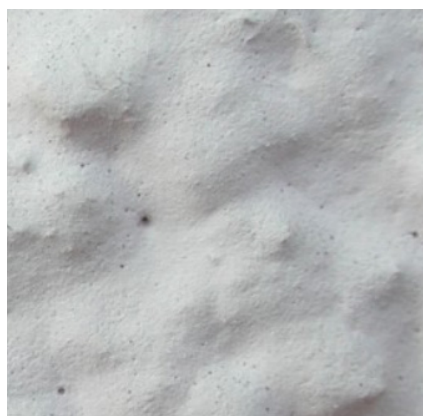
Détail d'une façade avec revêtement protecteur.
