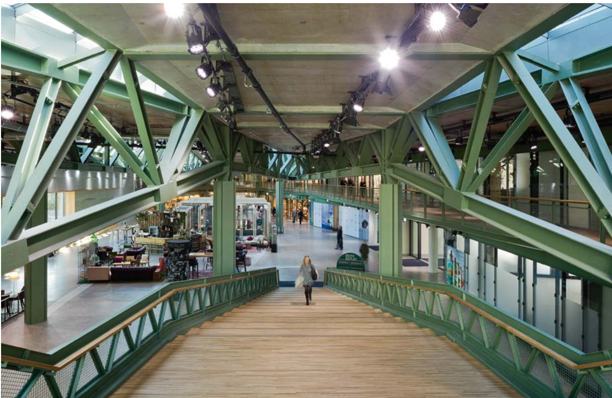
Eine große „Zugangsbrücke“ und unverkleidetes, grün gestrichenes Stahlfachwerk prägen die „etwas andere Shoppingmall“.
