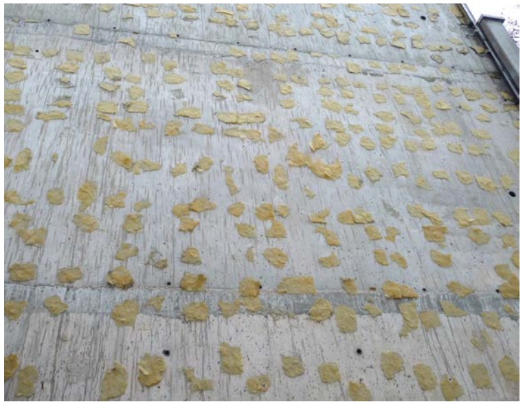
Die Betonaußenwände mit den Dämmstoffresten.
