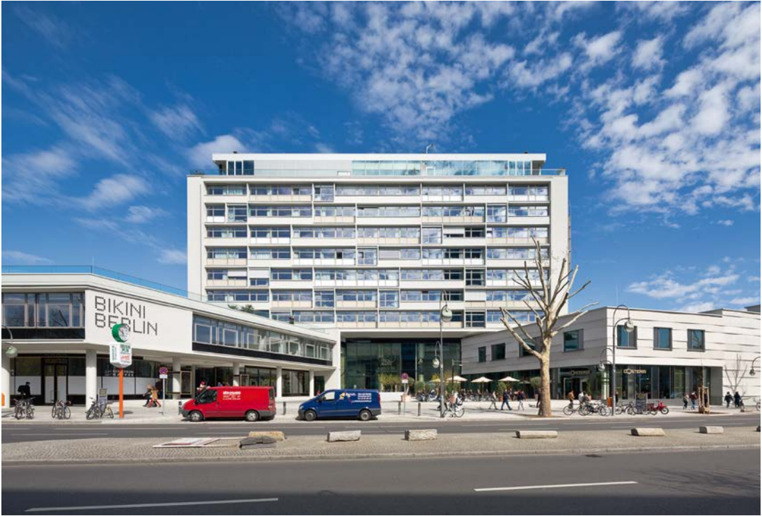
Das „Kleine Hochhaus“, das früher Bürogebäude war, beherbergt heute ein Hotel. Seine denkmalgeschützte Südfassade wurde rekonstruiert.
