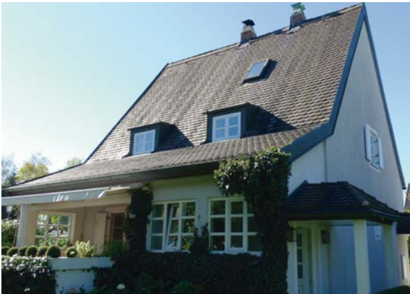
Münchner Testgebäude 2014 fotografiert. Das Gebäude hat in den 30 Jahren keine Bauschäden bekommen.
